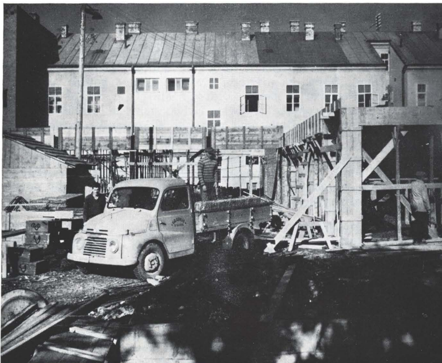
Početak gradnje novog dijela zgrade
