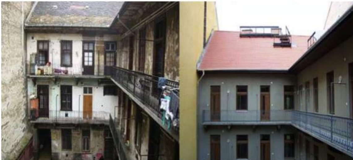
Slika 9. Obnova ulice Luzja, prije i poslije
