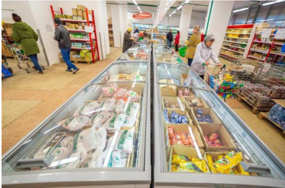
Slika 9. Prikaz zatvorenih hladnjaka u prodavaonici
