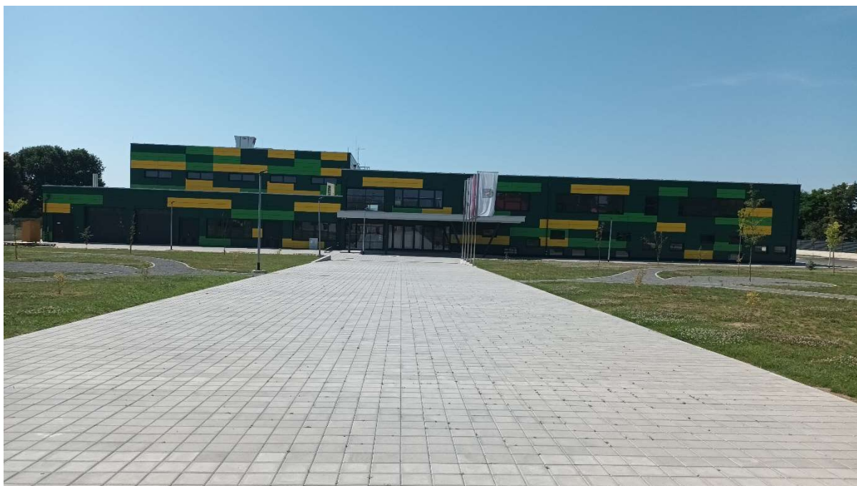
Slika 4.3. Pogled na sjeverno pročelje, glavni ulaz u školu i natkriveni trijem
