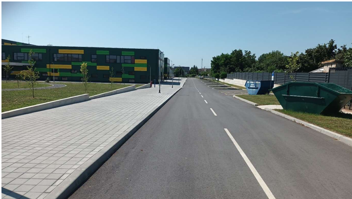
Slika 4.2. Interna prometnica, popločenje pješačke staze i parkirališna mjesta
