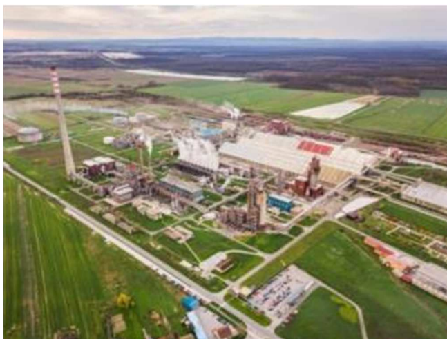
Slika 11. Panoramski pogled na dio postrojenja Petrokemije d.d.
