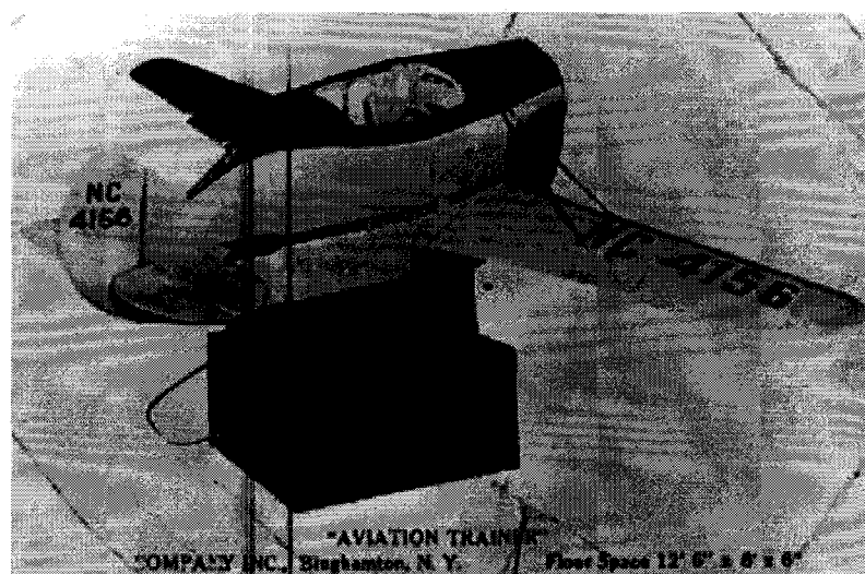
Slika 15 Prvi simulator leta izumljen od Edwin Linka, Izvor: Sherman i Craig (2018:31)
