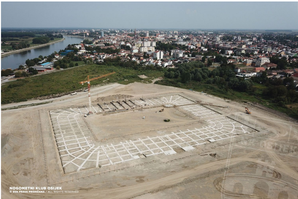
Slika 9. Radovi na Pampasu
