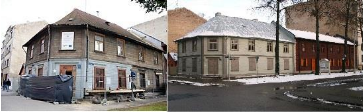
Slika 11. Obnova drvene zgrade, prije i poslije
