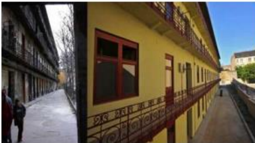
Slika 7. Primjer obnove, prije i poslije
