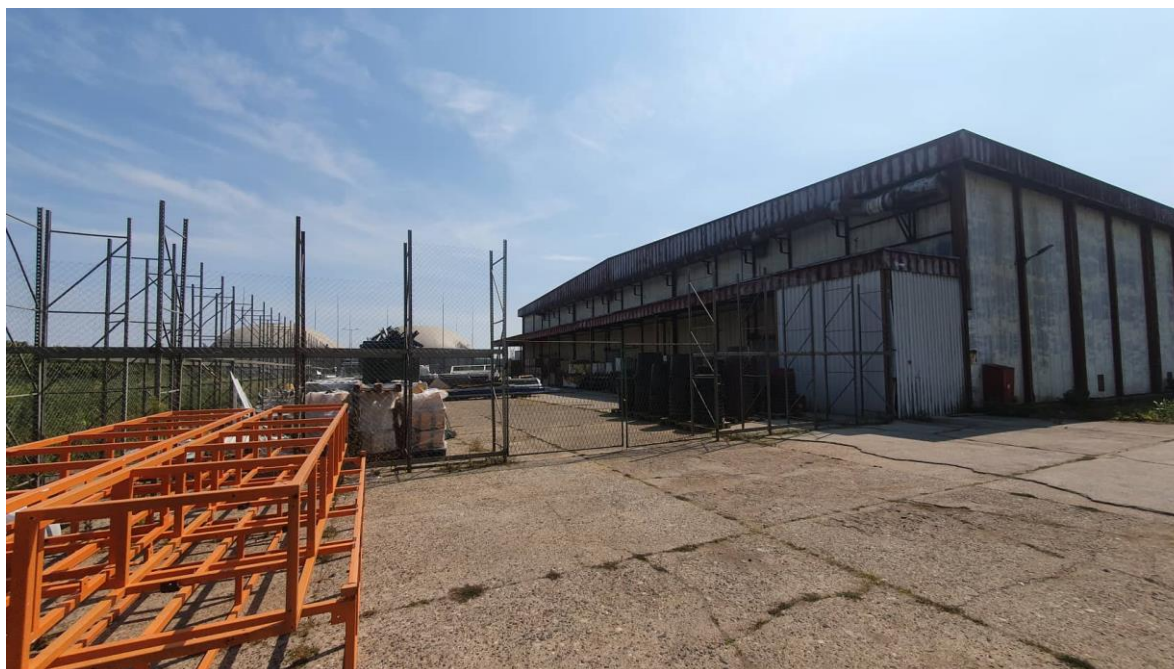
Slika 16. Otvoreni dio skladišta „Vinka“
