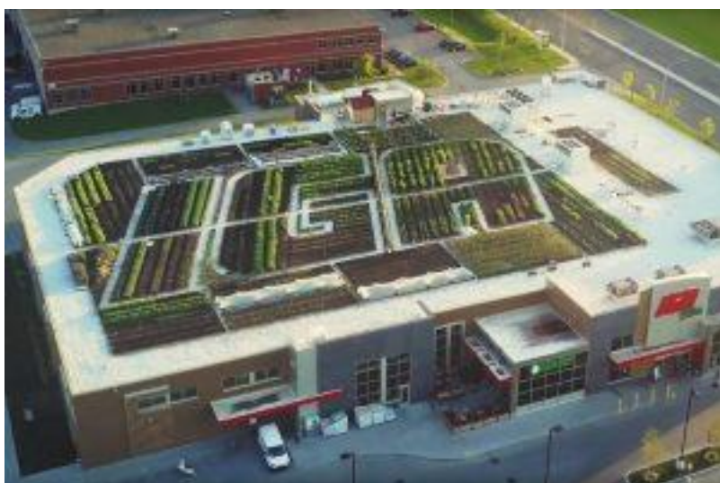
Slika 11. Vrt na krovu
