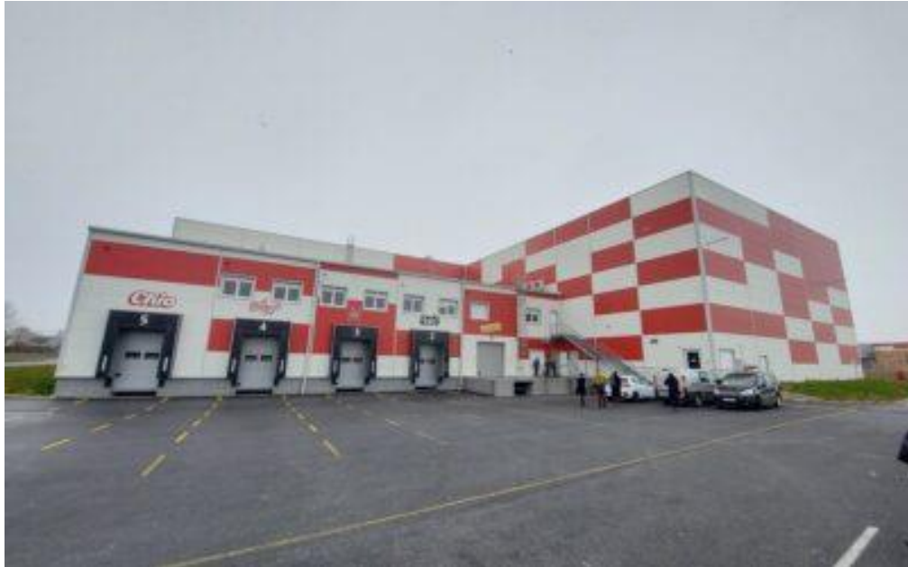
Slika 2. Skladište čipsa u Hercegovcu
