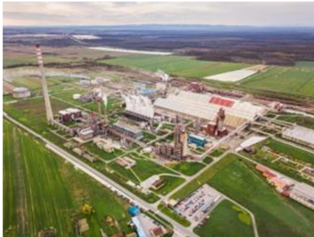
Slika 11. Panoramski pogled na dio postrojenja Petrokemije d.d.
