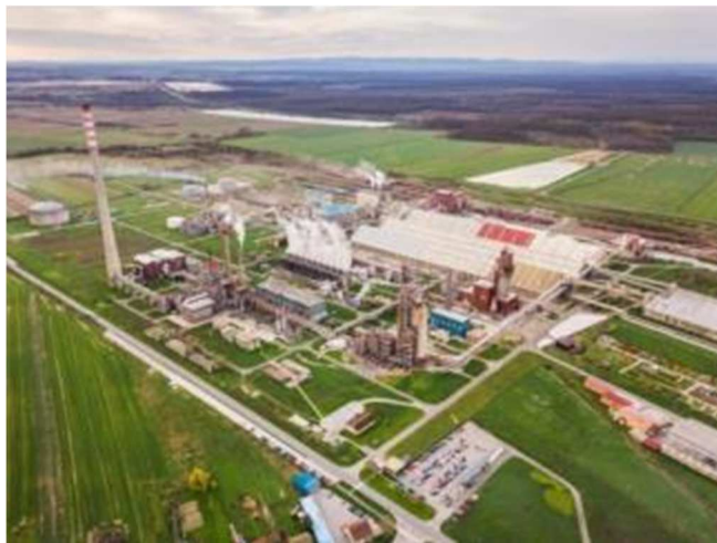
Slika 11. Panoramski pogled na dio postrojenja Petrokemije d.d.
