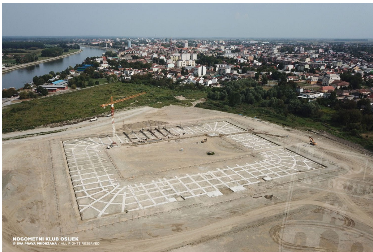
Slika 9. Radovi na Pampasu
