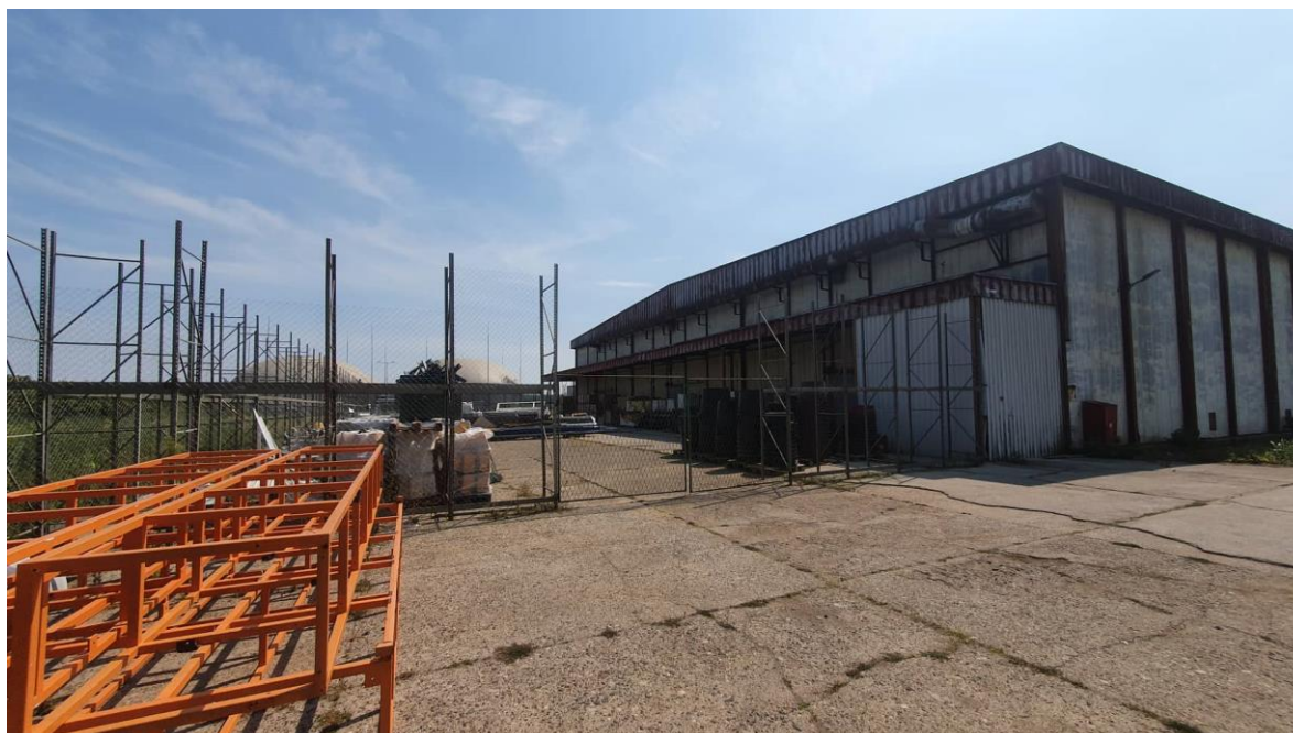
Slika 16. Otvoreni dio skladišta „Vinka“
