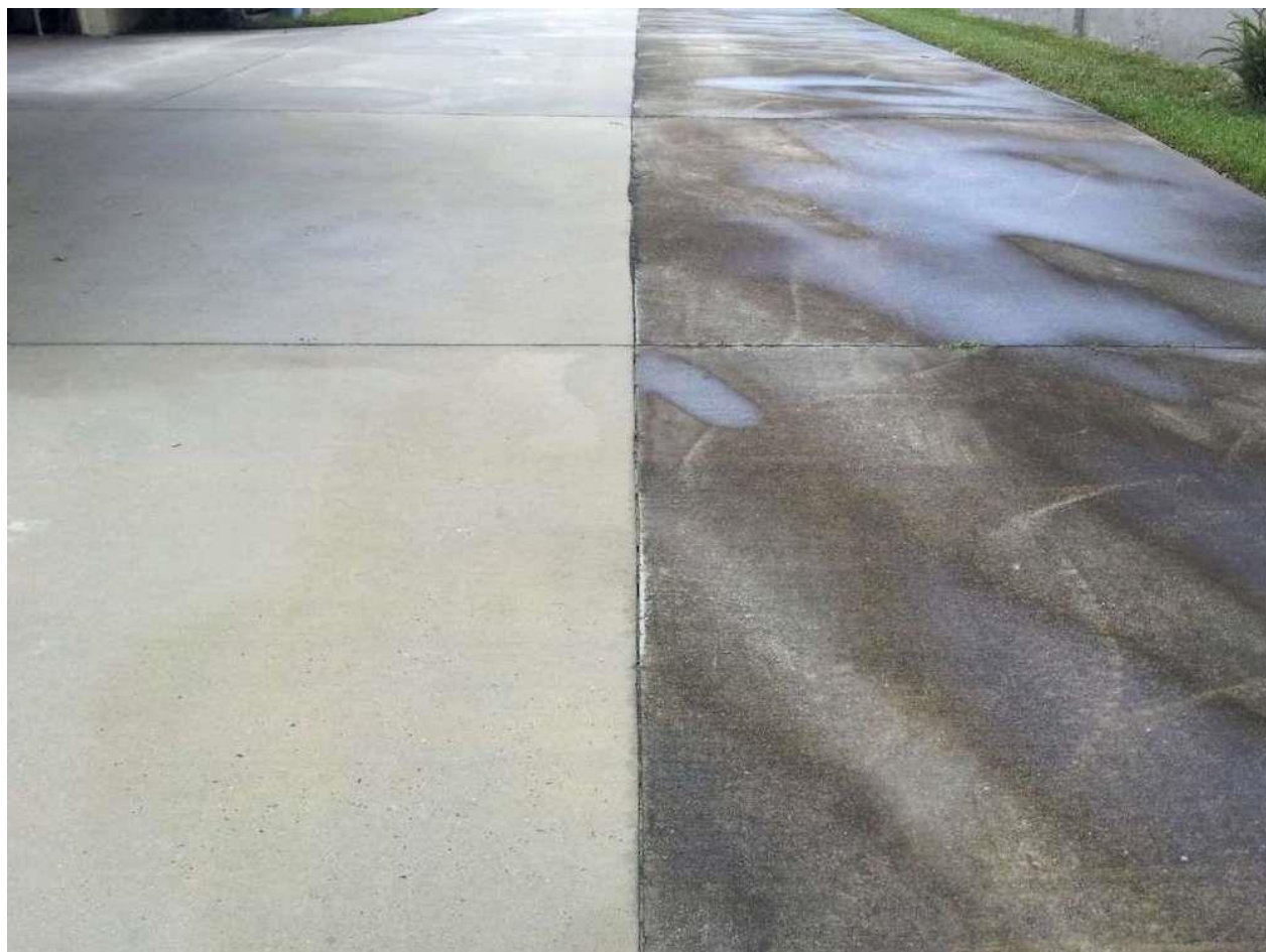
Slika 6. Čišćenje prilaza visokotlačnim čistačem
