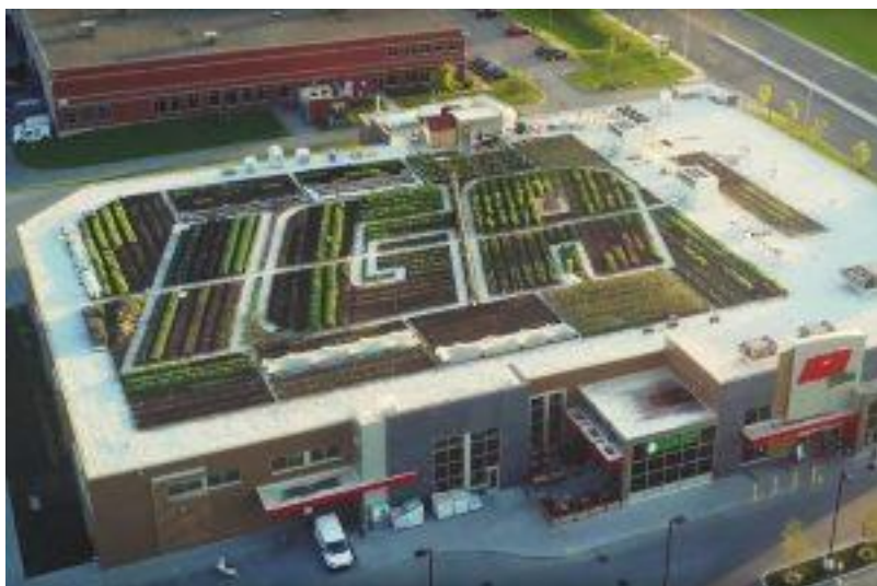
Slika 11. Vrt na krovu
