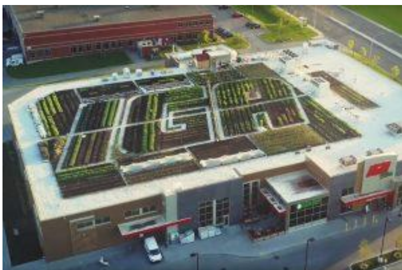
Slika 11. Vrt na krovu
