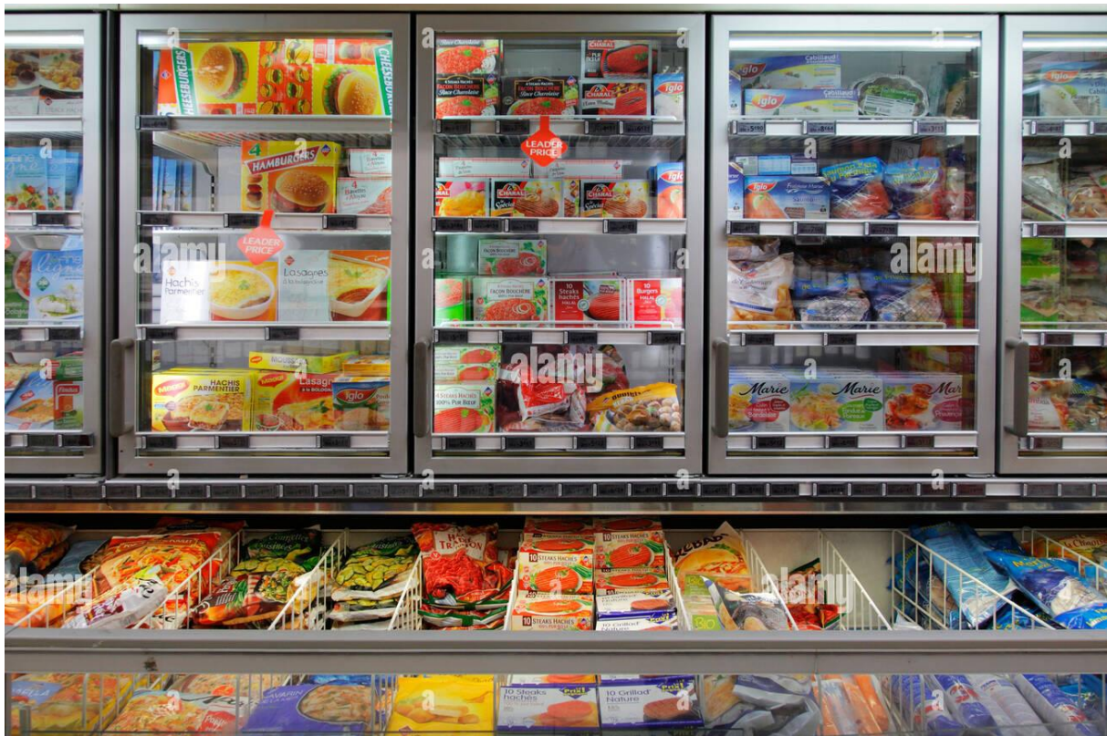
Slika 11: Hladnjaci u prodavaonici (Burmeister Holger, 2012)
