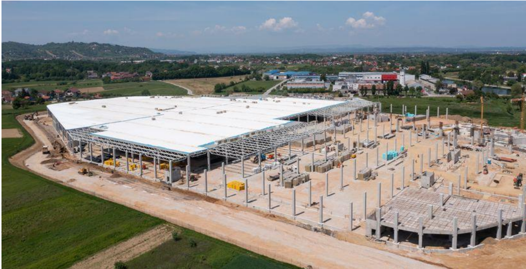
Slika 6. Gradnja Rimac Campus-a
