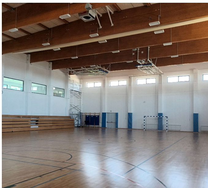
Slika 4.5. Parketni pod u sportskoj dvorani i krovni nosači od LLD-a
